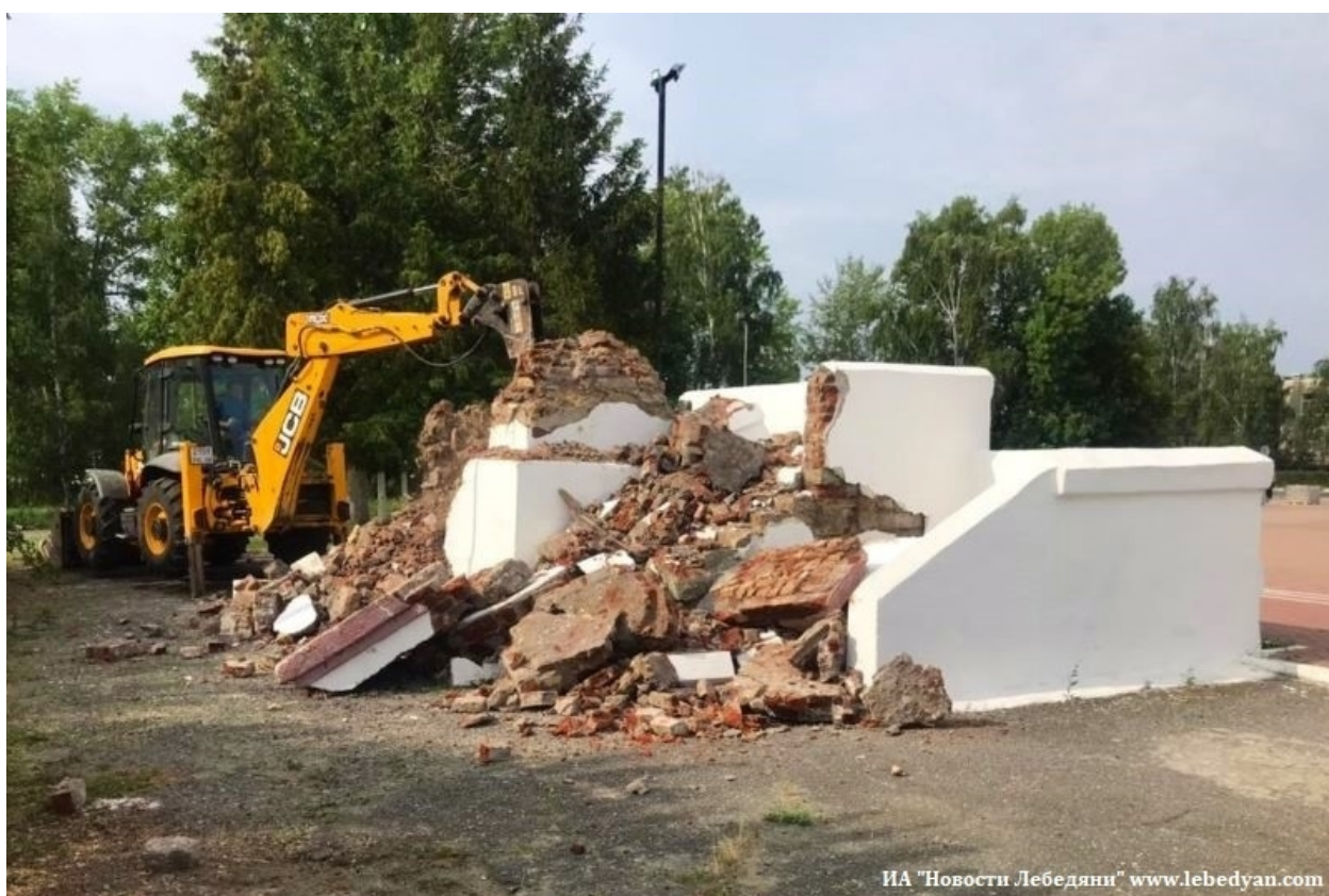
Демонтаж трибуны вместе с памятником вождя (2021 г.). Кирпич, по всей видимости, тоже христианский.
